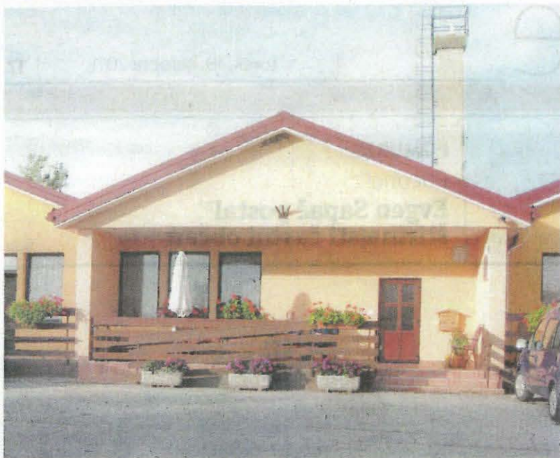
Nekdanja stavba osnovne šole je postala prijazen dom varovankam in varovancem zavoda Hrastovec. (Darja Lukman Žunec)
